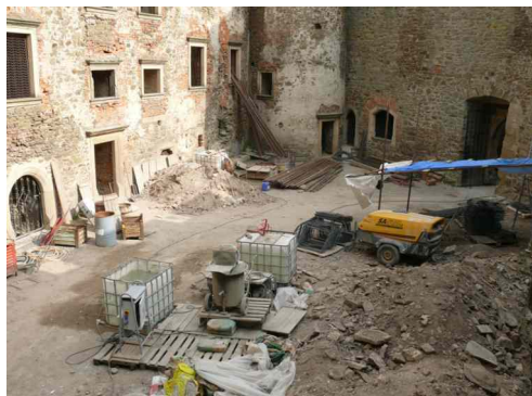
Stavební práce na nádvoří hradního paláce.
